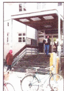
Eingang in die Post J.F. Kennedy-Straße
